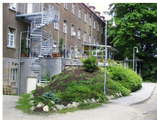
Rückansicht mit Hintereingang zum Saal (hier wird geladen)
